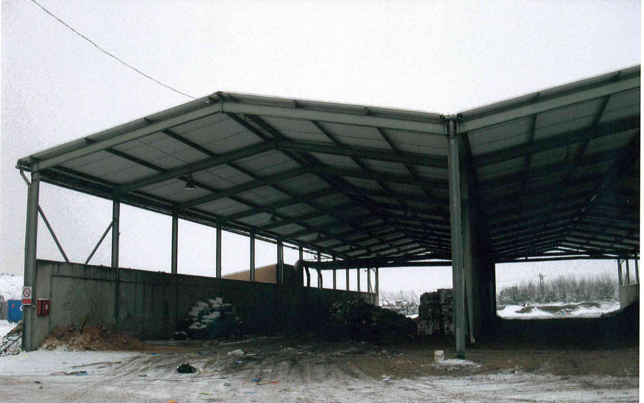
widok ogólny hali od strony wschodniej
