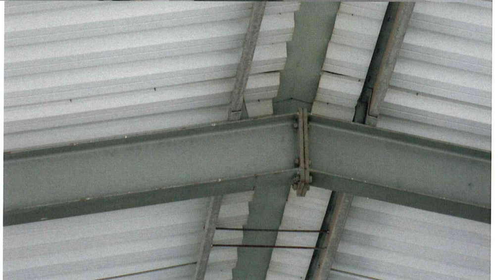
widok przykładowych węzłów konstrukcji hali –stan zadowolający
