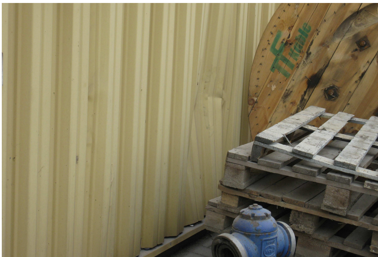
przykład uszkodzenia-wgniecenia blachy obudowy –elewacja wschodnia
