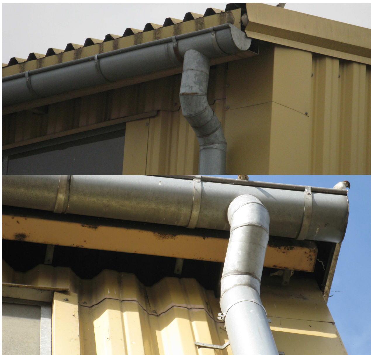
widok stanu technicznego pasa okapowego-stan zadowalający
