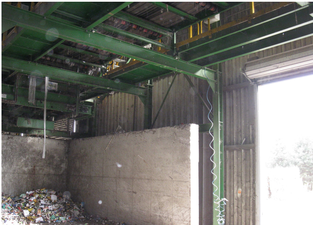
część sortowni-przyjęcie odpadów widok wnętrza hali sortowni –konstrukcja nośna hali sortowni w kolorze szarym , elementy w kolorze zielonym –istniejąca konstrukcja podporowa ciągów urządzeń technologicznych , ściany żelbetowe –zasieki z samodzielnymi fundamentami
