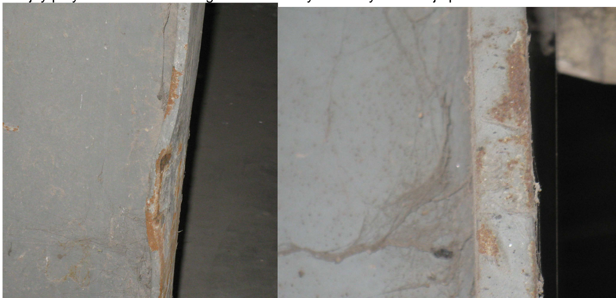
uszkodzenie słupa nośnego konstrukcji hali ( elewacja południowa) , korozja powierzchniowa
