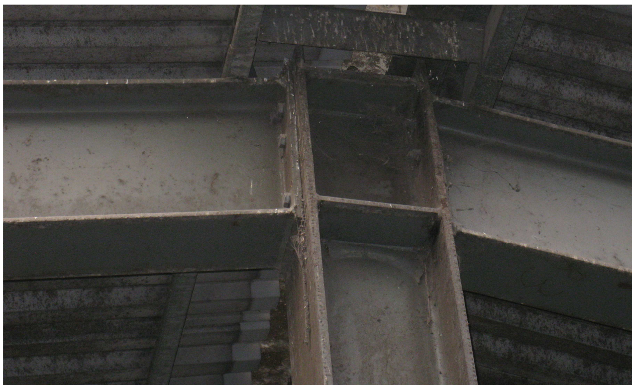
konstrukcja ram nośnych hali sortowni –widok stanu technicznego węzła przy kalenicy-silnie zanieczyszczony –brak deformacji i przemieszczeń
