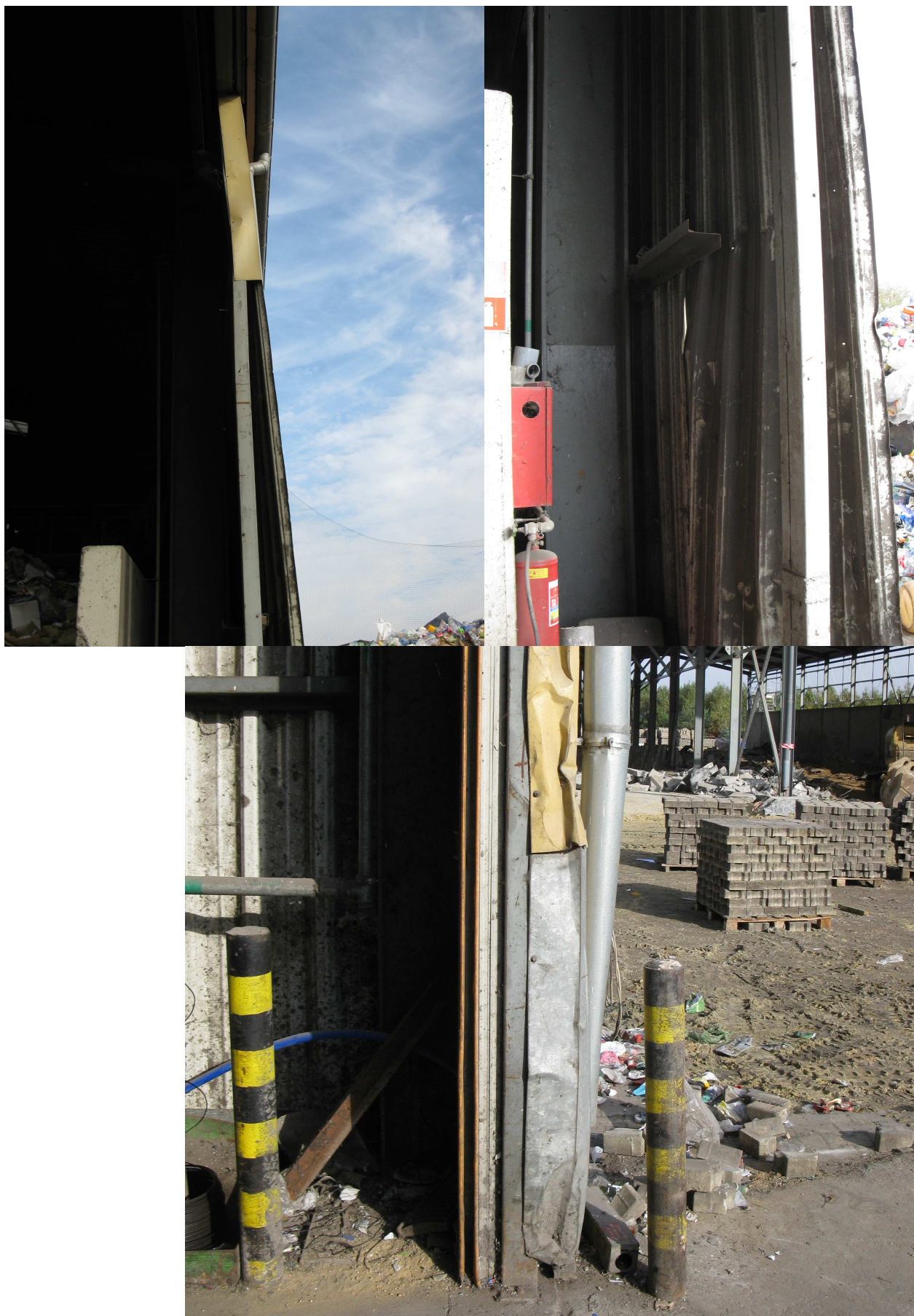
przykład usadzenia obudowy oraz słupków stalowych w rejonie bram wjazdowych do budynku hali sortowni
