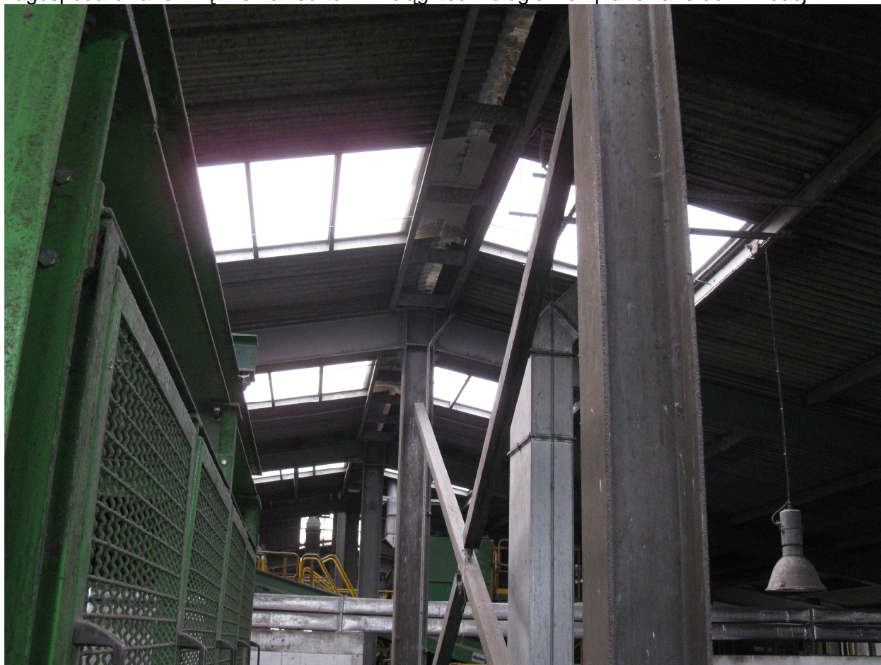
widok wnętrza hali sortowni –konstrukcja nośna hali sortowni w kolorze szarym , elementy w kolorze zielonym –istniejąca konstrukcja podporowa ciągów urządzeń technologicznych
