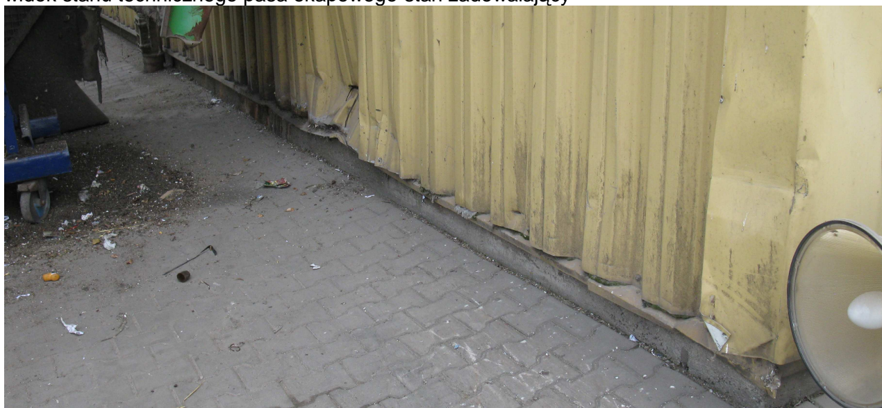
uszkodzenia blach obudowy hali w rojnie pasa przyziemia.
